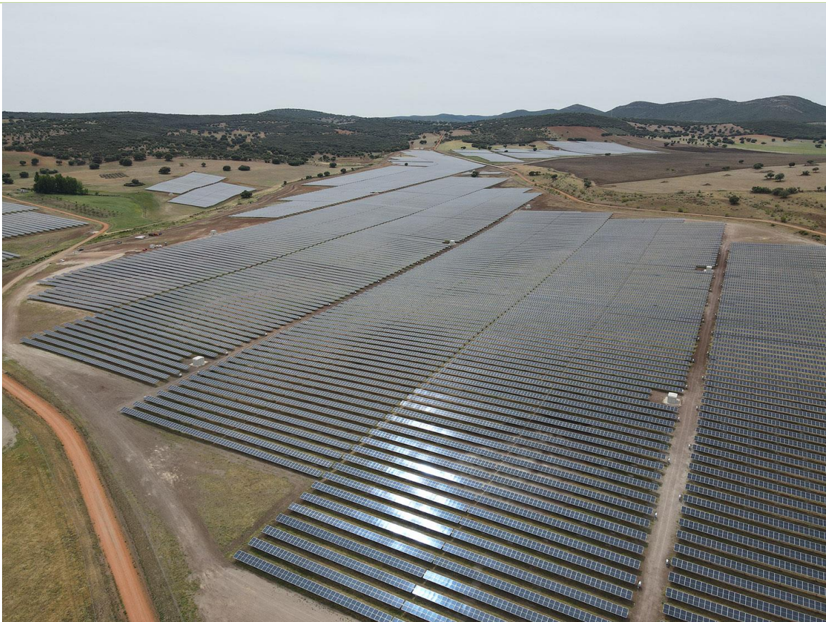
Joonis 3. Vaade Zimmermanni paneelidega tracker süsteemis ehitatud PEJ-le Hispaanias, Piconis ( https://pv-tracker.de/ ).
